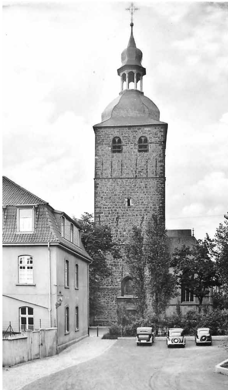
Die Propsteikirche St. Peter in den 1950er Jahren (Foto: Institut für Stadtgeschichte).
