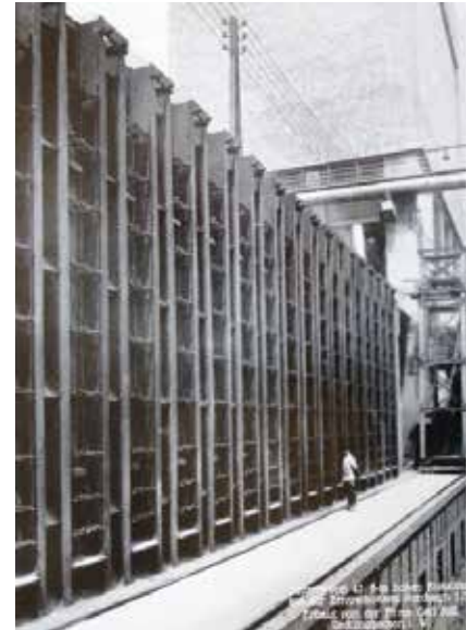
Die ersten 6m hohen Öfen auf der Zentralkokerei Nordstern (etwa 1929), gebaut von der Firma Still (Institut für Stadtgeschichte).
